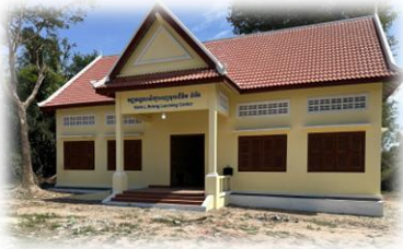
寺子屋の建設
