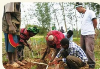
▲簡易水道の設置工事
