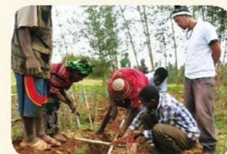
▲簡易水道の設置工事
